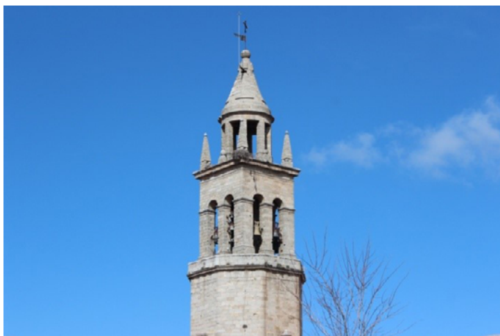
Fig. 3. Torre parroquial de El Salvador, Pedroche, Córdoba. Último cuerpo y chapitel de Juan de Ochoa, 1588. Fotografía del autor.
