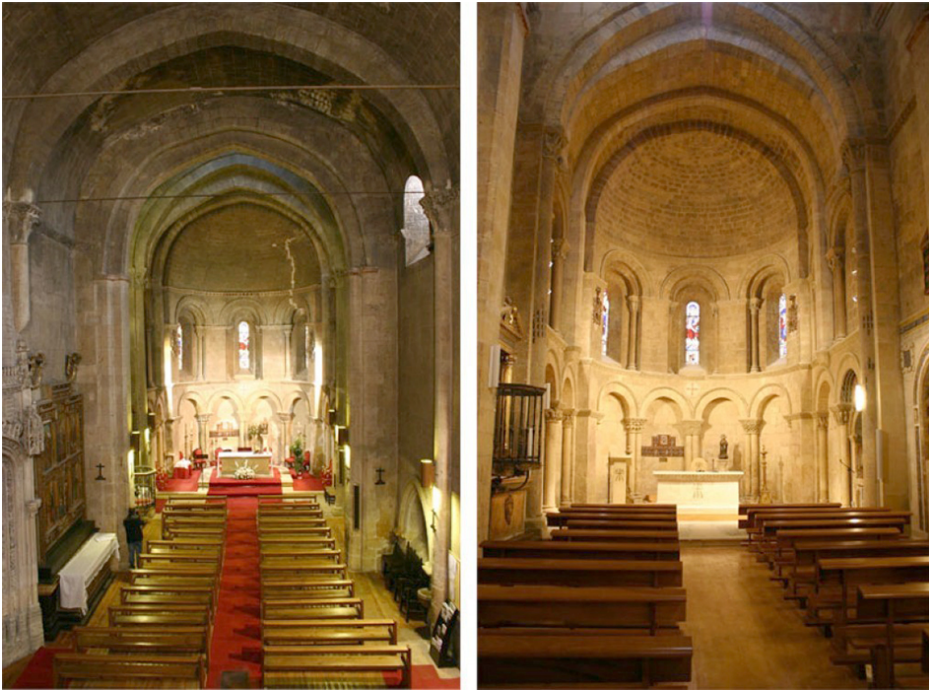
Fig. 7. Anónimo, Bóveda de cañón en el interior de la iglesia de la Santísima Trinidad, aproximadamente siglo XI, España, Segovia.
