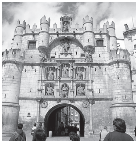
Foto 10. Fachada principal del Arco de Santa María de Burgos. 1531-1553.
