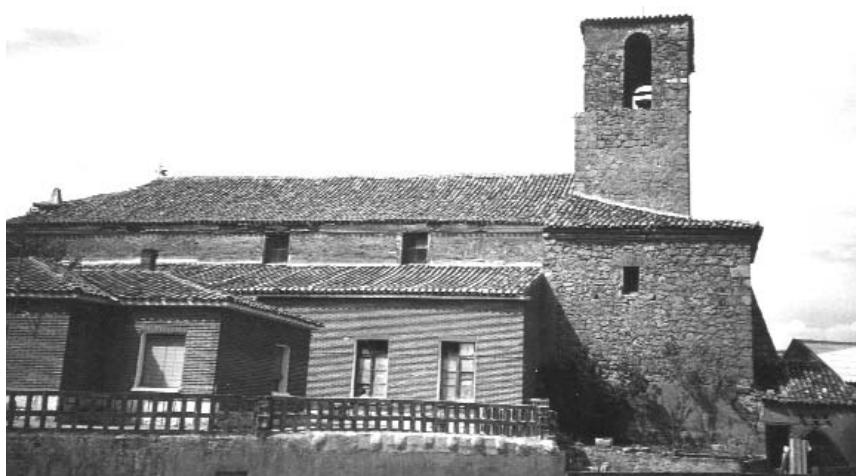
Foto 2. Cabrereros del Monte (Valladolid). Iglesia de San Juan Bautista.
